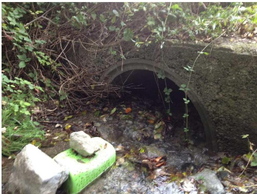
Figura 33 – Tratto intubato quasi completamente ostruito in corrispondenza della strada poderale nei pressi di Chessin
