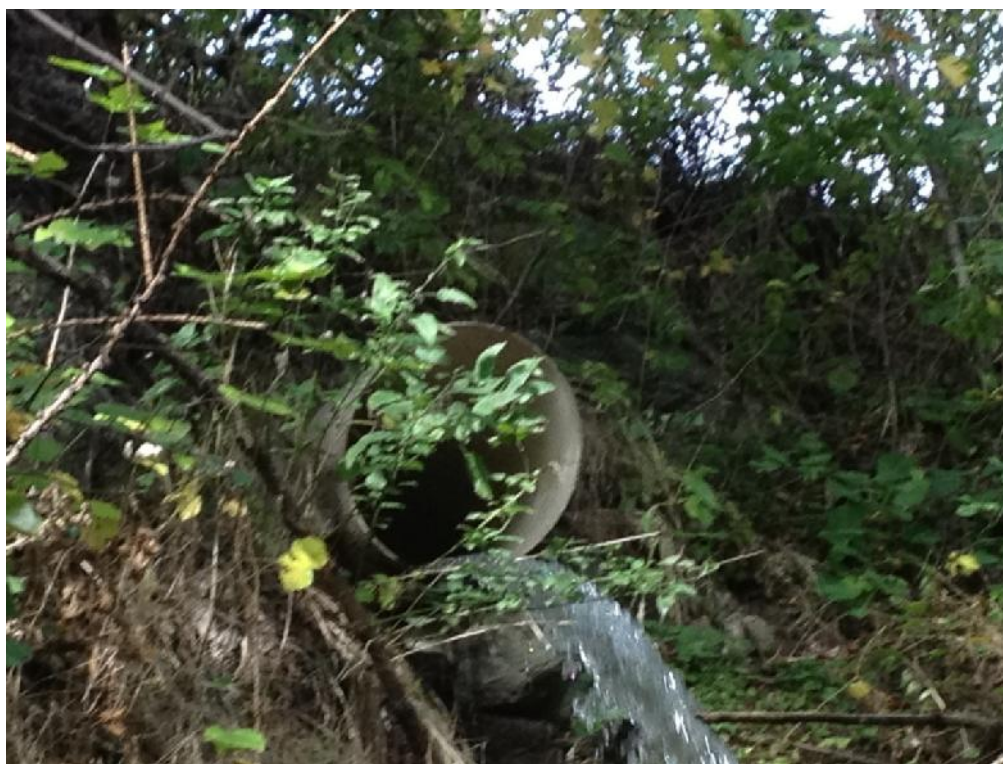
Figura 28 – Fine tratto intubato DN500, a valle dei pascoli in loc. Berzin
